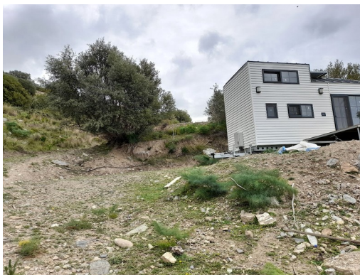
Erste Unterkunft während der Bauphase.
